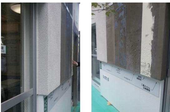
発泡プラスチック系断熱材による外壁の外断熱改修事例
